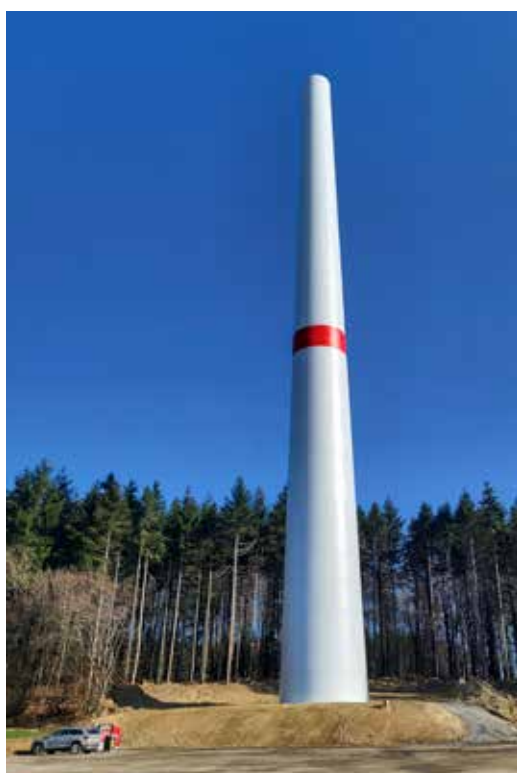
In Bau befindlicher Windpark Dünfus
